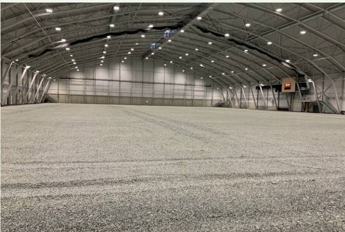
I dag ligger det pukk i hallen. Under ski-VM vil det bli montert midlertidig gulv over pukken i mediesenteret.
