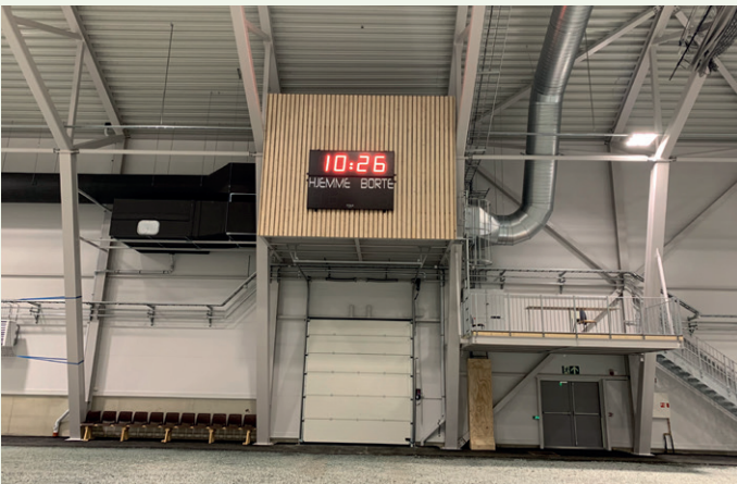
En gangbru under taket i hallen er bygget for teknisk drift.
