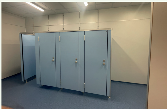
Toalettene i spillergarderoben.
